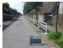
安全施設工事 施工前→施工後
